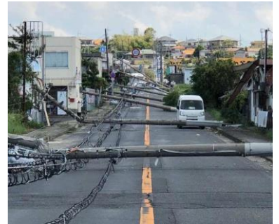
台風21号 被災状況(2018年) (大阪府泉南市)
