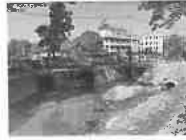
市内排水路の現状 2018 (H30) . 11. 28
