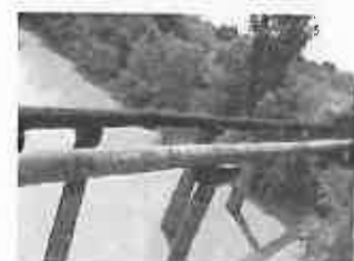
水管橋（鋼管、コンクリート管）の 状況確認
