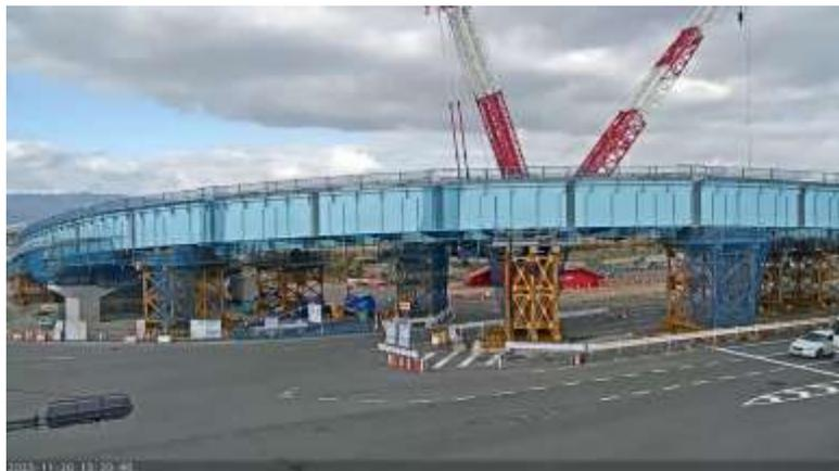
(仮称) 夢洲北高架橋主桁架設完了 (令和5年11月)
