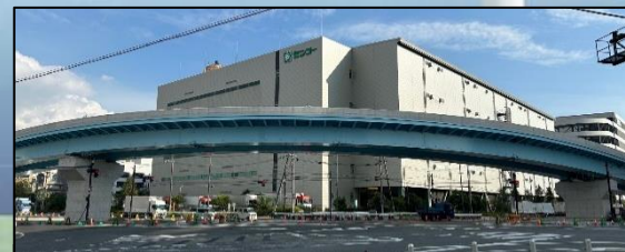
(仮称) 舞洲東高架橋 右折2車線 (夢舞大橋→此花大橋) ■令和6年12月下旬完成予定
