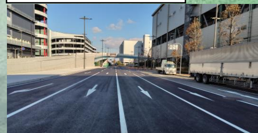
施工後（直進3車線）
