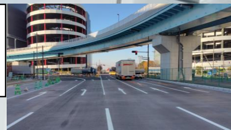
施工後（左折2車線化）
