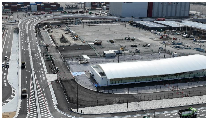
夢洲南高架橋【令和6年12月2日より利用開始】
