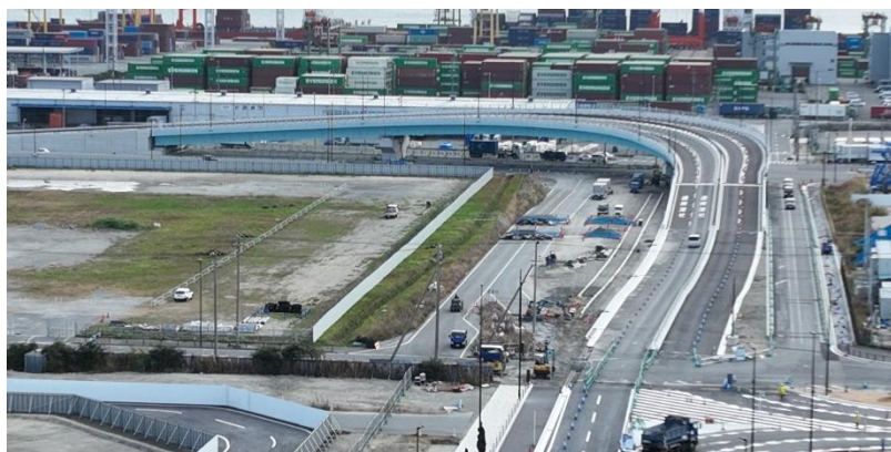
夢洲北高架橋【令和6年8月1日より利用開始】
