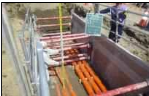
電気管路敷設状況
