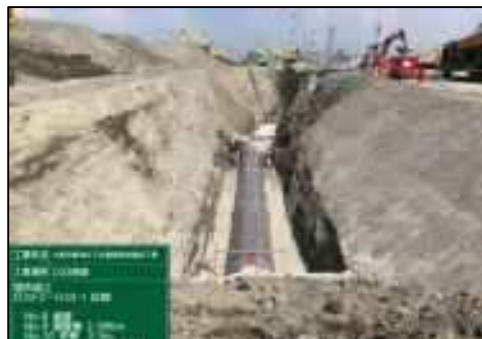
下水道管敷設状況
