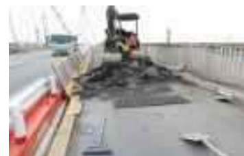
施工中(歩道舗装撤去)
