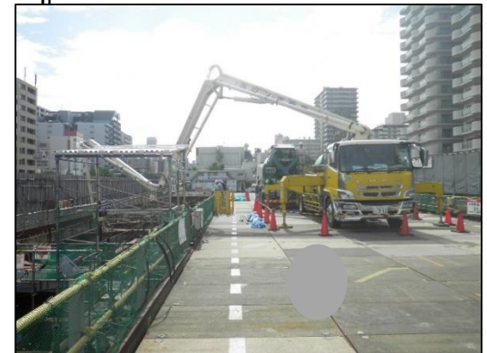
(参考) コンクリート打設状況
