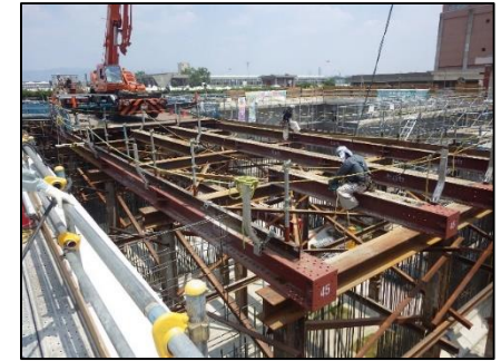
(参考) 仮栈橋撤去状況
