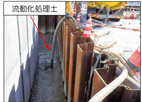
(参考) 流動化処理土埋戻し状況
