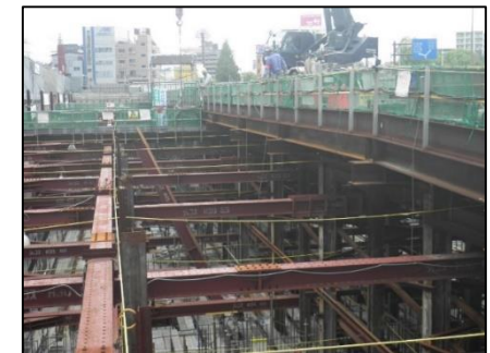
(参考) 土留支保工撤去状況
