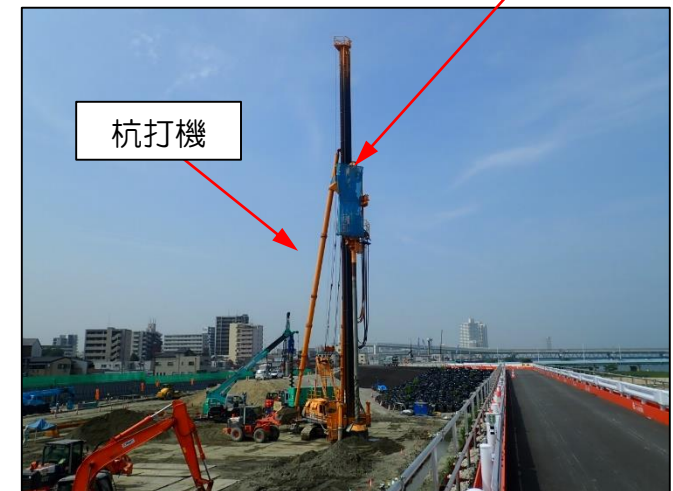
(参考) 砂杭工施工状況
