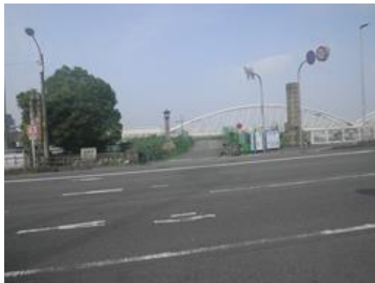
④国道176号出入口
