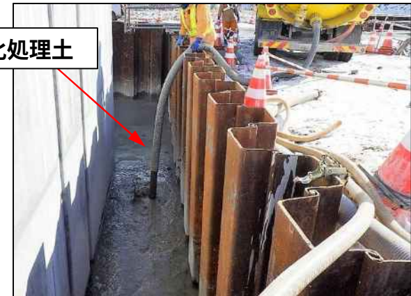
流動化処理土埋戻し状況写真
