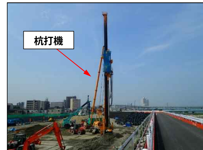
砂杭工施工状況写真
