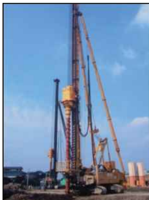
固結改良状況写真
