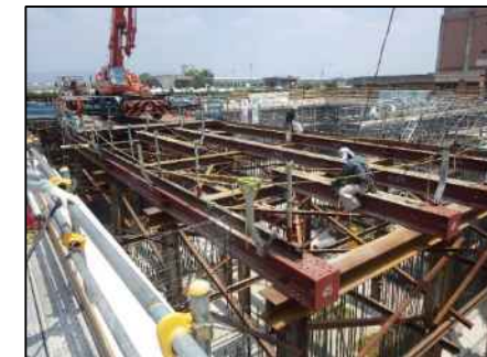
仮栈橋撤去状況写真
