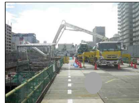
コンクリート打設状況写真
