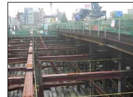
土留支保工撤去状況写真
