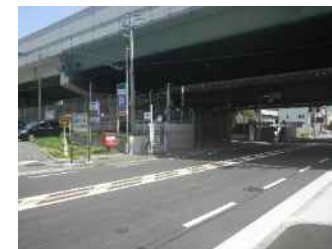
阪神高速高架下出入口
