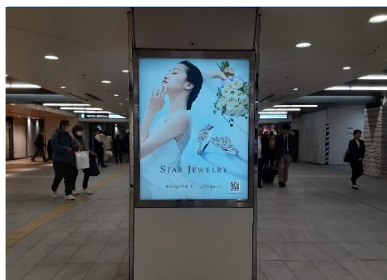
中央広場 (電照看板) ※蛍光灯から LED 照明へ更新
