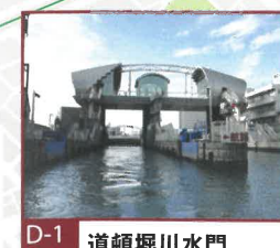
D-1 道頓堀川水門 平成13年3月に完成した水門で、東横堀川水門と対になって機能しています。水門の詳細な内容は裏面をご覧ください。
