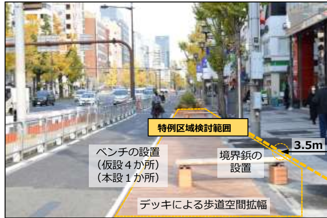
〔図〕側道閉鎖区間での検証
