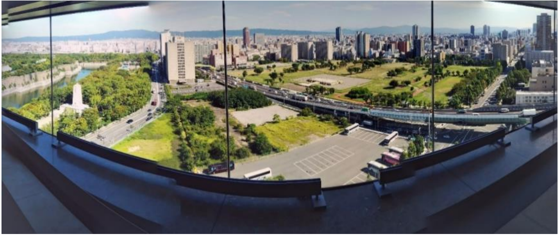
図 55 大阪歴史博物館 10 階展示室より難波宮跡北部および南部ブロックを望む
