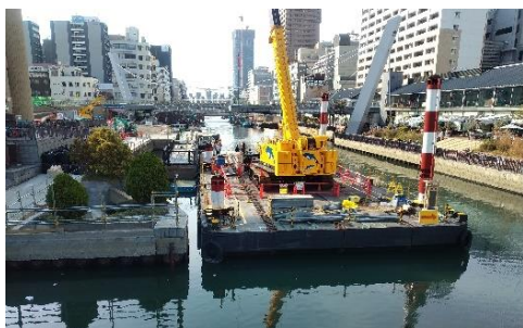
湊町エリアの工事 (深里橋～浮庭橋 左岸)
