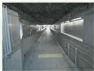
設置前の通路内部
