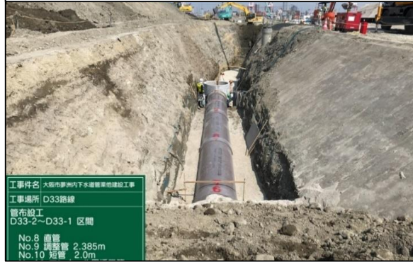
【7】下水管敷設工事の状況
