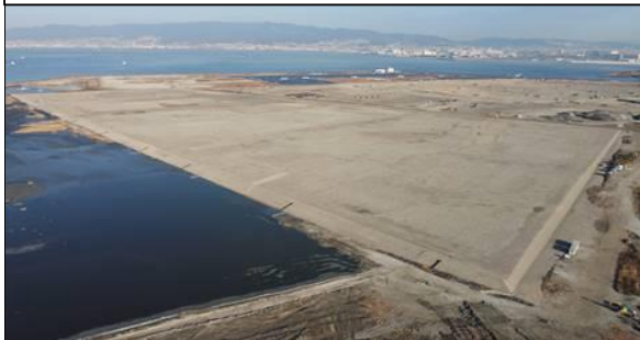
【1】【2】埋立・盛土工事の完了
