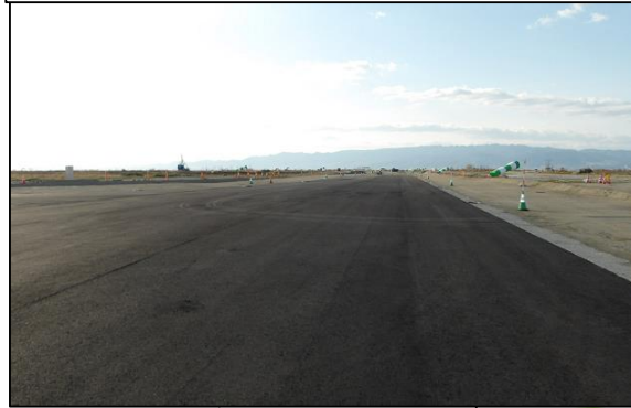
【5】観光外周道路新設工事の状況
