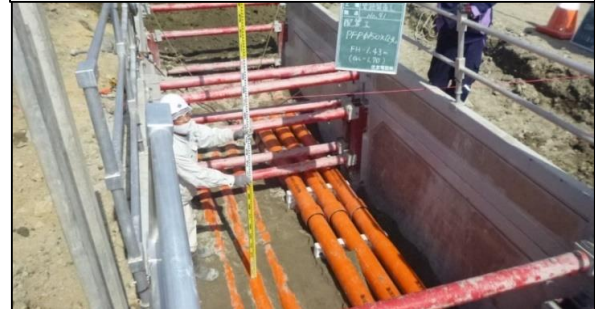
【9】電気管路敷設工事の状況
