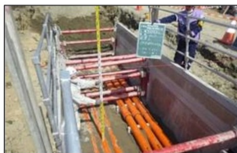
電気管路敷設状況
