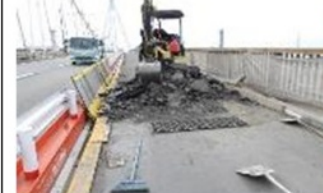
施工中(歩道舗装撤去)
