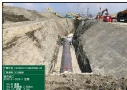
下水道管敷設状況
