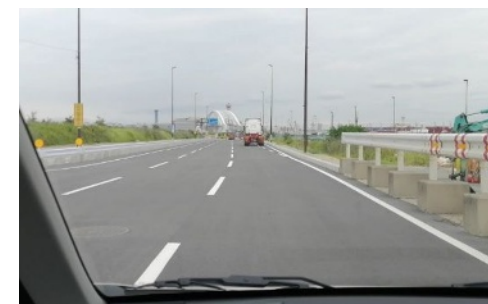
現在の幹線道路の状況
