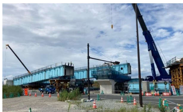
(仮称) 夢洲北高架橋架設状況 (令和5年9月現在_前回報告時)
