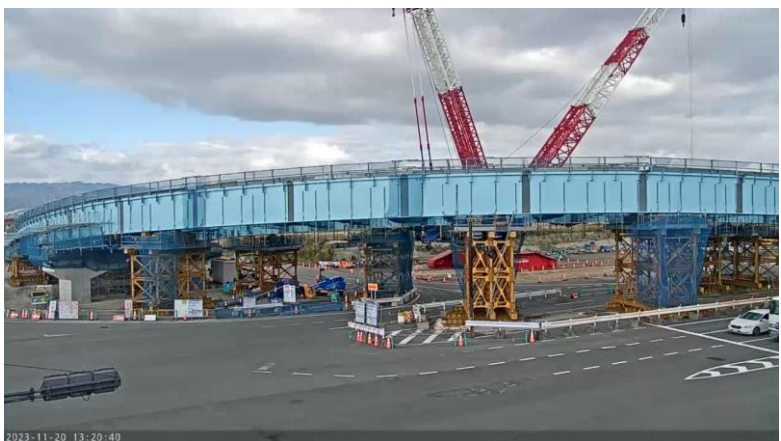
(仮称) 夢洲北高架橋主桁架設完了 (令和5年11月)
