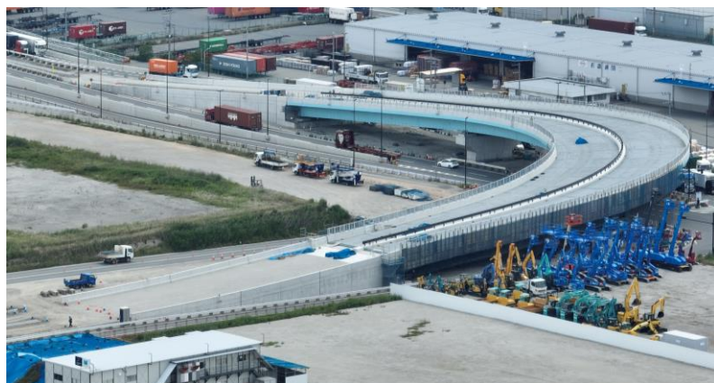
(仮称) 夢洲北高架橋主桁架設完了 (R6年5月時点)
