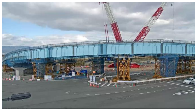
(仮称) 夢洲北高架橋架設状況 (R5年11月時点)
