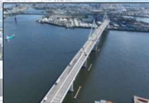
此花大橋 (4車線⇒6車線) ■令和4年10月供用済
