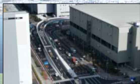
舞洲東高架橋 (夢舞大橋→此花大橋) ■令和6年12月供用済
