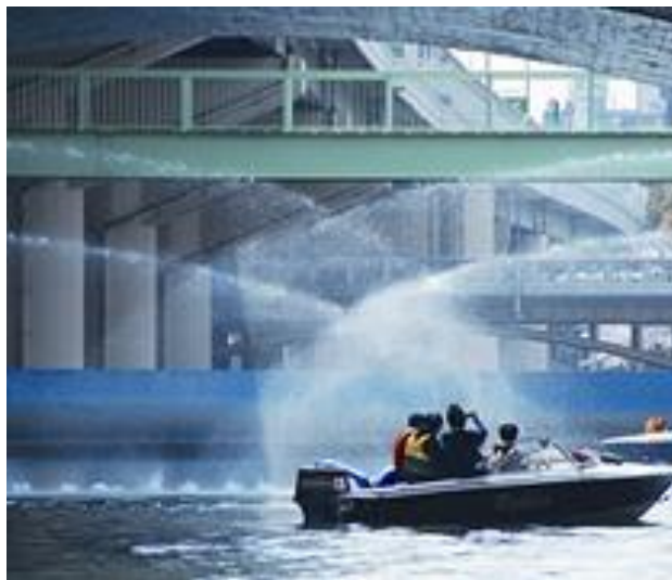
東横堀川水門
