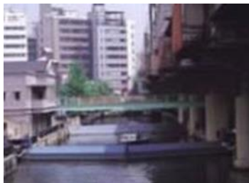
東横堀川水門
