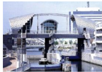
道頓堀川水門
