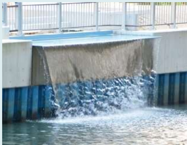
本町橋北側に整備されたMBR放流口
