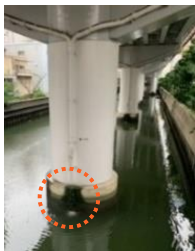
阪神高速の路面排水の流入
