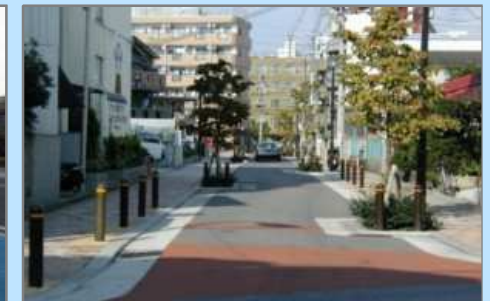
生活道路における通過交通の抑制 (コミュニティ道路の整備)
