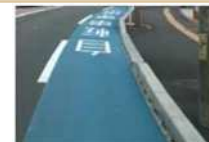
＜自転車の走行性に配慮した排水構造の例＞
