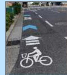
▲幹線道路における矢羽根型路面表示等の設置状況(上町筋)
