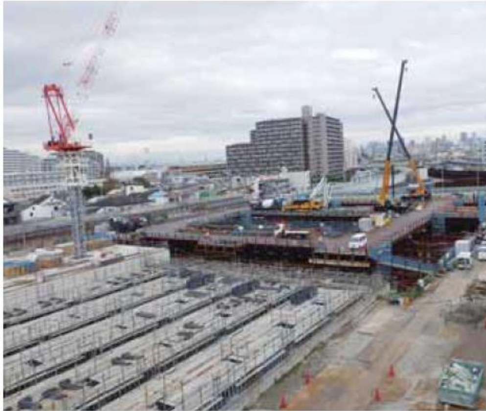
此花下水処理場内ポンプ場(工事中)
