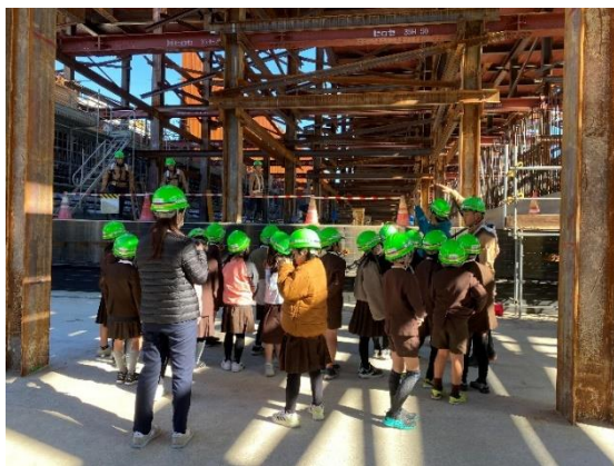
▲工事用棧橋（作業構台）の下（地下）に降りてトンネル構築中の現場を見ているようす
