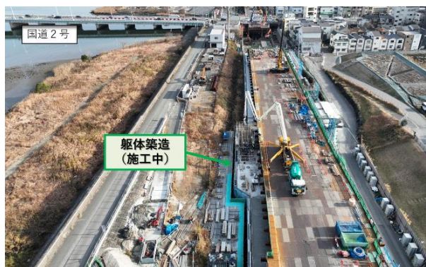
▲ 1工区（海老江JCT～JR神戸線）の工事状況（R5.12月）
