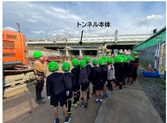
▲トンネル本体ができている箇所を見ているようす
