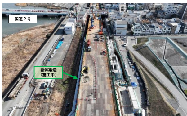
▲ 1工区（海老江 JCT～JR 神戸線）の工事状況（R6.2月）
