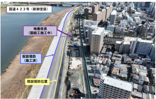
▲ 3工区（阪急電鉄～新御堂筋）の工事状況（R6.2月）
