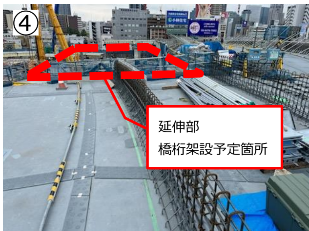
写真④：将来、淀川左岸線延伸部の橋桁が架かる予定の場所です。延伸部の橋桁を架設することを見越した形状になっています。
