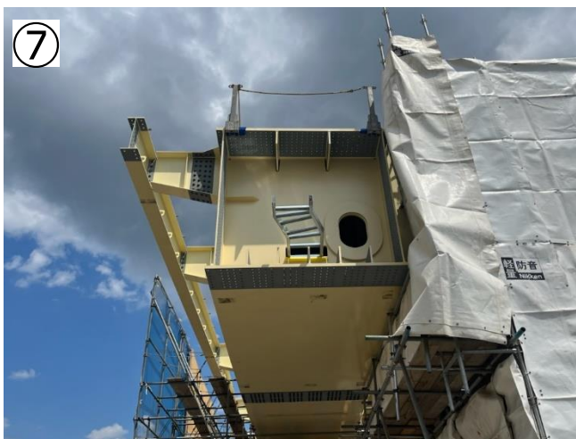
写真⑦：橋桁を横から撮った写真です。
