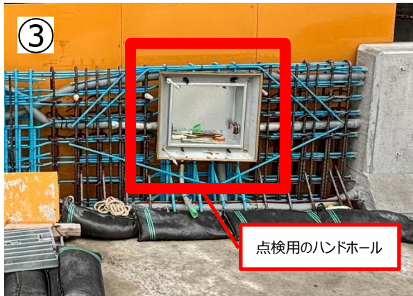
写真③：写真②で作業中の高欄部分を近くから撮った写真です。
