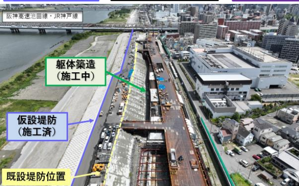
▲ 1工区（海老江 JCT～JR 神戸線）の工事状況（R6. 8月）
