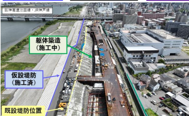
▲ １工区（海老江 JCT～JR 神戸線）の工事状況（R6. 8月）
