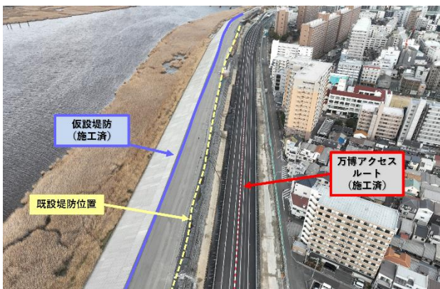
▲ 3 工区（阪急電鉄～新御堂筋）の工事状況（R7.2 月）
