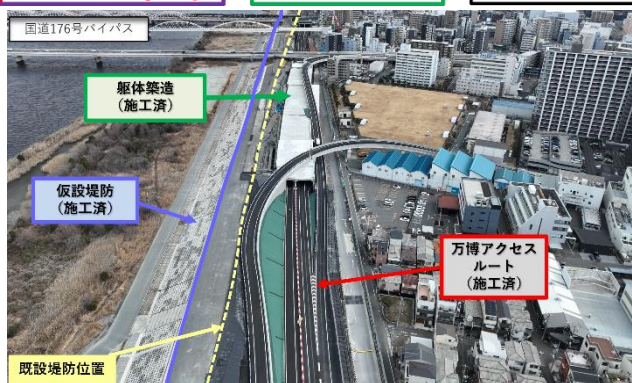
▲ 2 工区（JR 神戸線～阪急電鉄）の工事状況（R7.2 月）
