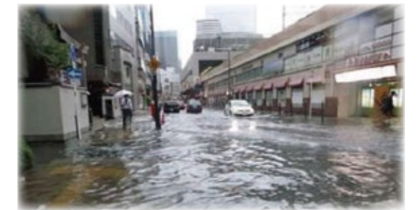
平成25年8月25日の浸水状況(大阪市北区)
