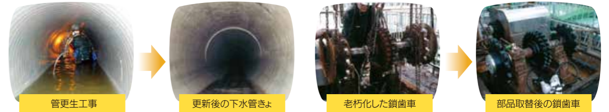
管更生工法(管きょの改築手法)
