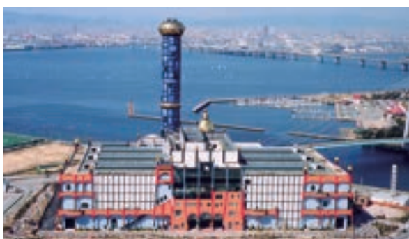
舞洲スラッジセンター
