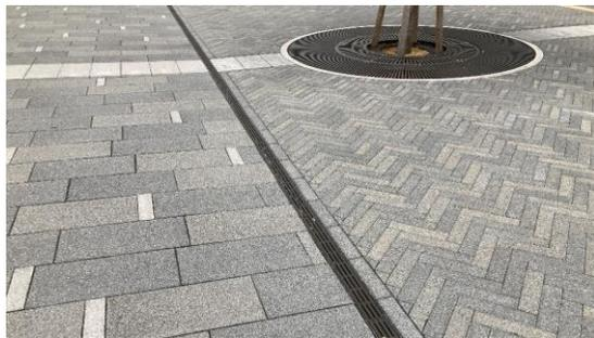
スレンダー側溝を配置することで、側溝自体が空間の境界を明示する機能を持っています。（中之島通）
