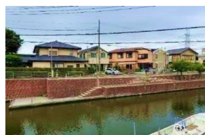
必要な護岸高を確保しつつ 親水性を確保した断面構成 のイメージ（事例：浦安市境川）
