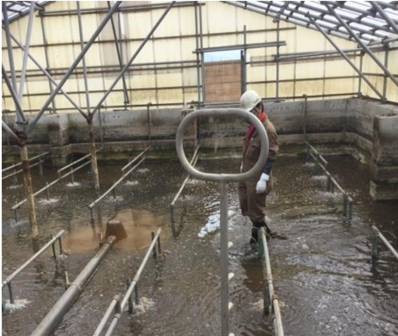
汚泥減量槽内部
