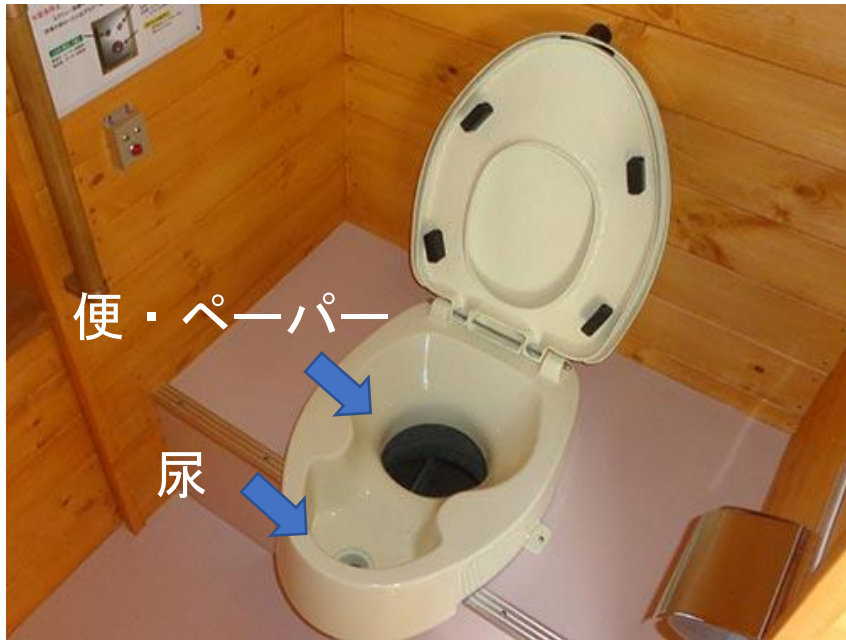
し尿分離トイレの例 便と尿の分離回収を目的とした便器
