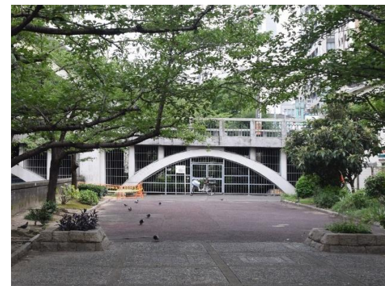
▼ 閉鎖された橋下空間（大手橋）
