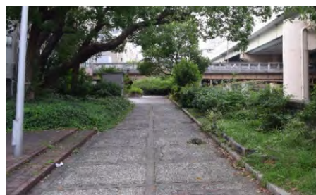
コンクリート舗装
