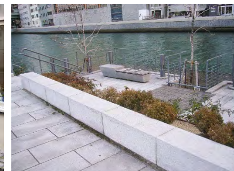
コンクリート石貼り（中之島公園）
