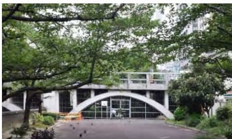
▼ 閉鎖された橋下空間（大手橋）
