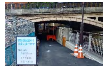
◀ 既存の橋下空間 (本町橋右岸)
