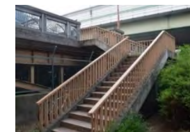
▼ 既存アクセス箇所 (平野橋橋上から)
