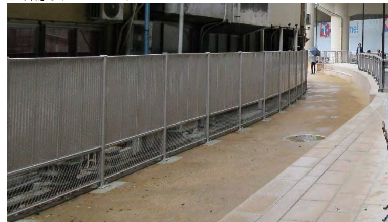
(改善の余地がある例) レール上面に支柱上端や接合部が突出し、煩雑な印象を与える。また、柵と並行する場合、柵とは別に手すり用の支柱を設けてしまうと煩雑な印象を与える。
