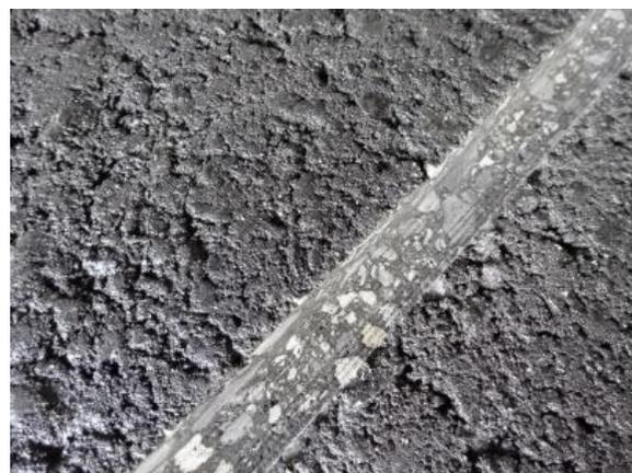
舗装された道路上の光ファイバを敷設する箇所(区画線にあたる場所)を、カッターを使用して切断し溝を作ります。海老江工区開削トンネル内の東行き・西行き道路それぞれ1車線の区画線下に光ファイバが敷設されます。
