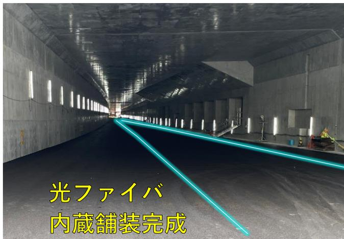
光ファイバの敷設・配線が完了した後は、溝を埋めるために樹脂モルタルを注入し、充填します。
