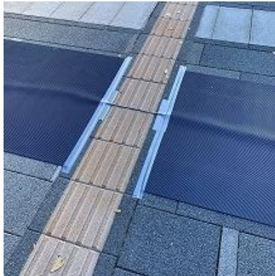
マット・テープによりはがれにくく通行の支障 になりにくい配線養生
