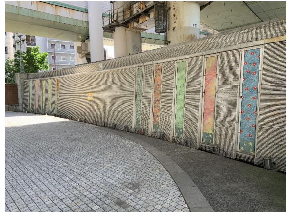
壁泉（稼働停止中）
