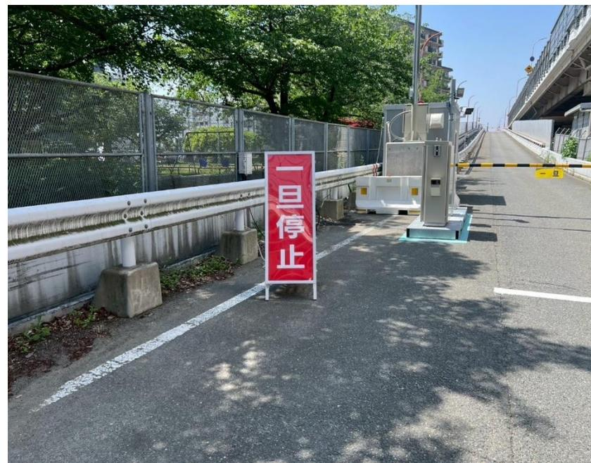
豊崎入口・大淀出入口・海老江入口に設置しているバーゲートの通過時には、車両番号の認識とバーゲート開閉のため、一旦停止していただくこととなっておりますが、バーゲート接触事故が数件発生しております。これを受け、運転手の方々への注意喚起として各バーゲート付近を中心に看板を増設しました。
