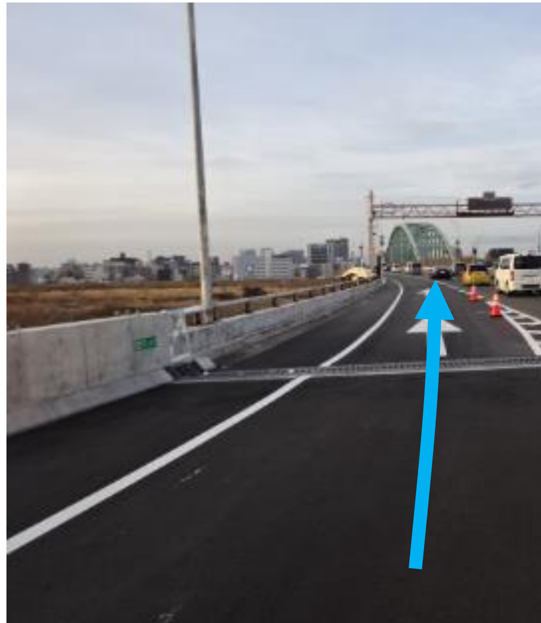
新御堂筋との合流部
